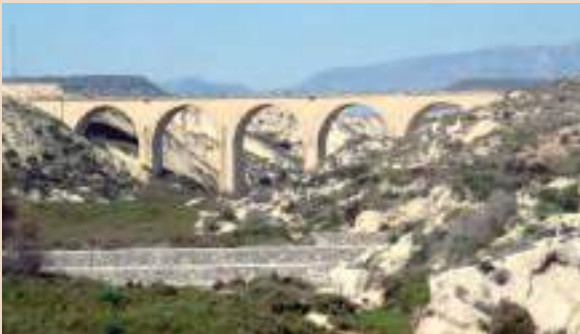
VIADUCTO RAMBLA DE GRACIA
