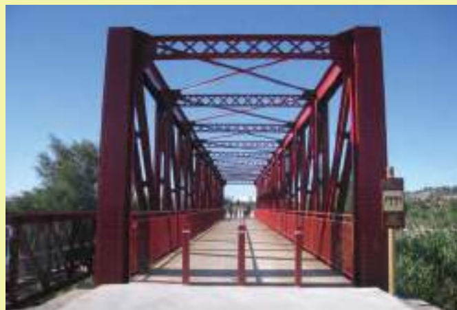
PUENTE SOBRE EL RÍO SEGURA
