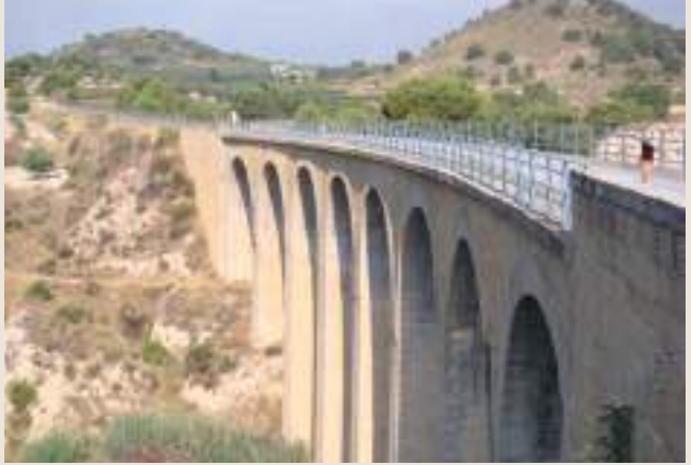
VIADUCTO DE LA LUZ. MULA
